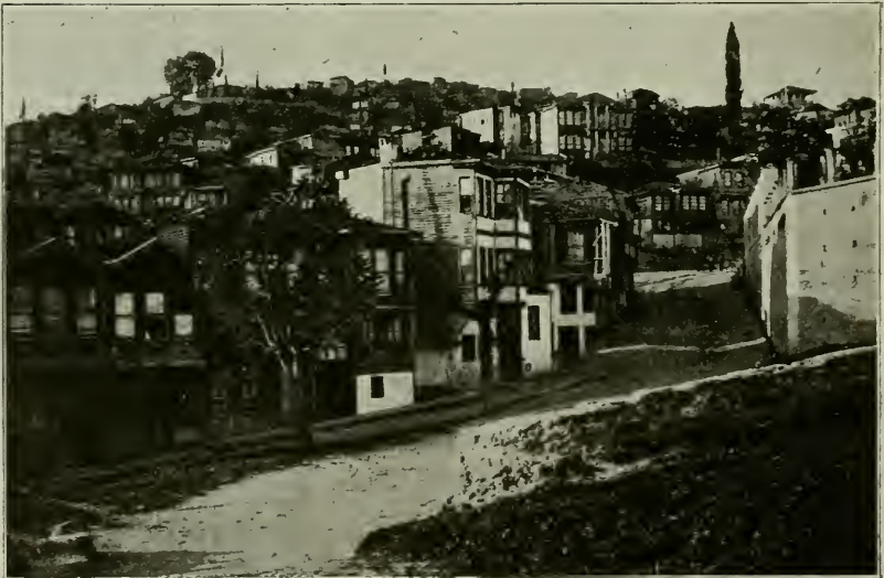
Abb. 17. Ismid, eine Griechenstadt mit Holzbauten
